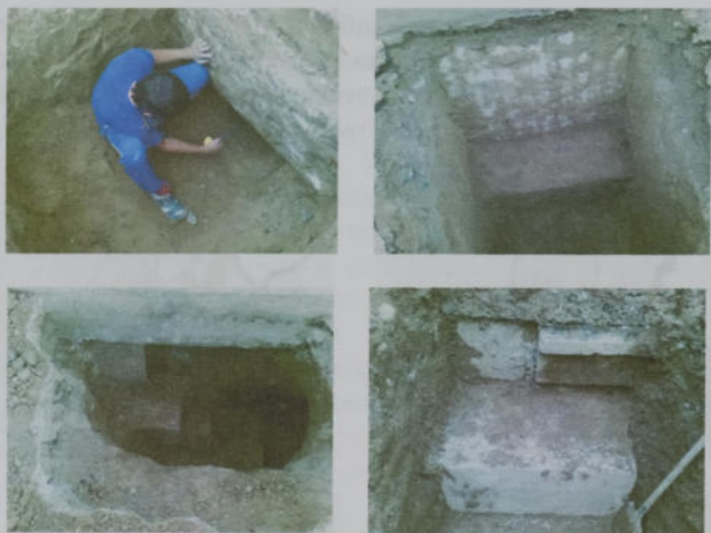
Рис.4.2. Обнажение фундаментов для их обследования и отбора проб грунта
