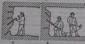
Расми 5.1. Пармакунии дастии рахнакҳо: а - якҷаҳсӣ; б - дуҷаҳсӣ
