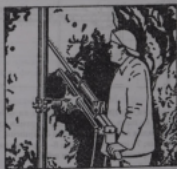
Расми 5.10. Ҳолати кори перфоратори сутуннишин дар кӯвишгоҳи нақб
